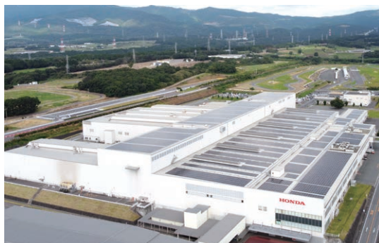
熊本製作所 (5.35MW)
