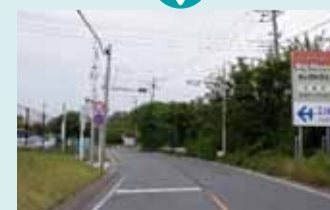
信号機の新設
