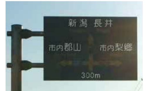
逆光現象対策標識（写真下）の採用によって判読性が大幅に改善された例
