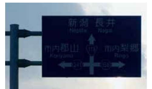
電気を使わず、手動で最大4つの表示に切り替えられる四可変標識
