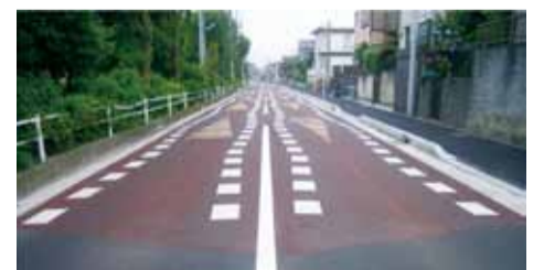
波状路面によってドライバーに速度抑制を促す「スピードセーブ工法」
