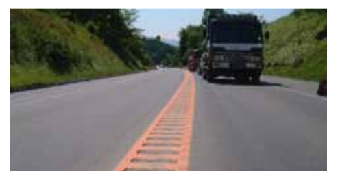
車線逸脱事故防止に効果を発揮する「ランブルストリップス」
