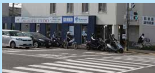
「片田」交差点にはすべての方向に二段停止線が設置されている
