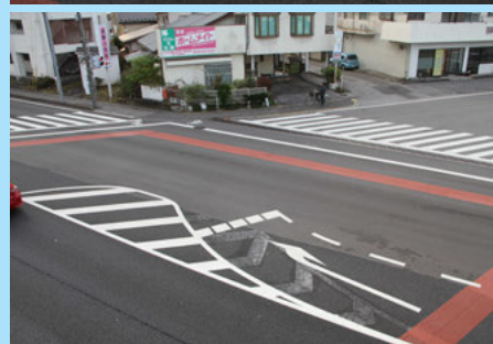
今年5月末の右直事故発生から2ヵ月後に交差点の内寄りに変更された右折待ちの停止線
