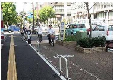
歩行者と自転車の通行分離柵が設けられた歩道
