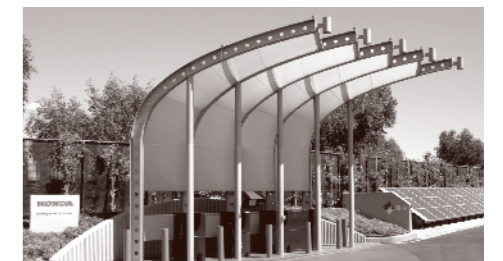
実験稼働中の太陽電池式水電解型水素ステーション Solar-powered hydrogen station
