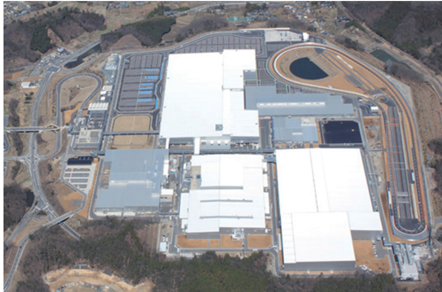
埼玉製作所寄居工場 鳥瞰写真
