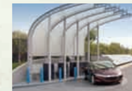
太陽電池式水素ステーション Solar powered water electrolyzing hydrogen station
